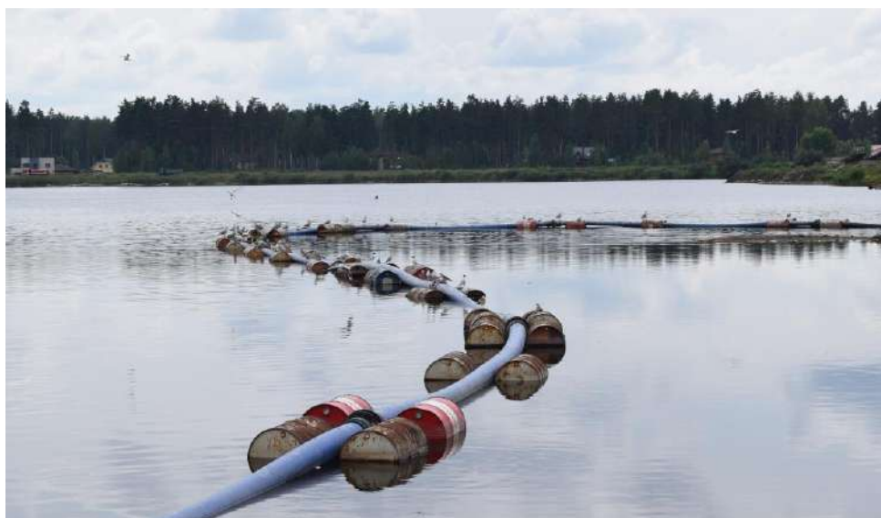
1.4.attēls. Smilts transportēšanas cauruļvads no zemessūcēja līdz atbērtnei
