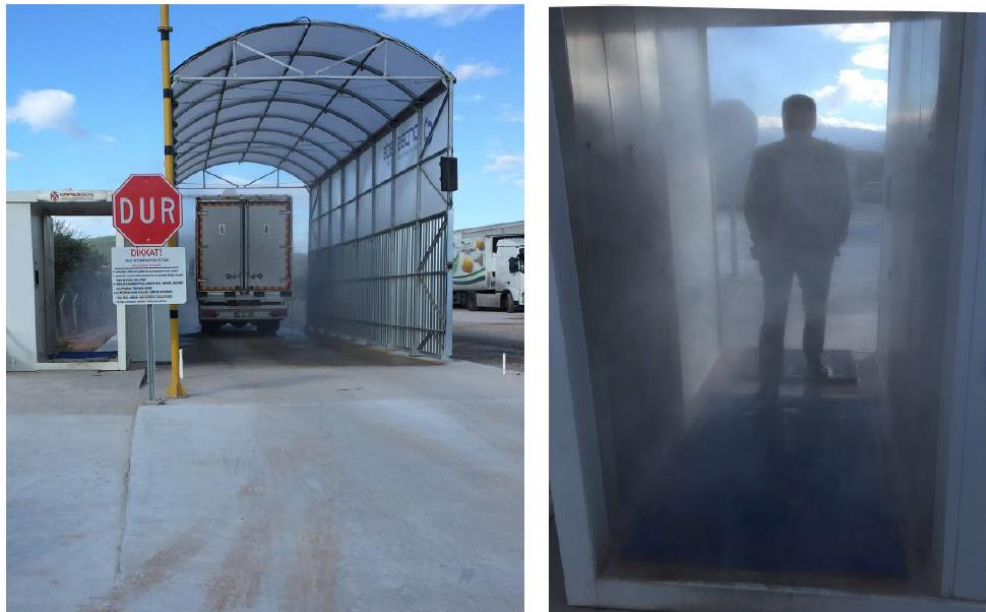
3.25. attēls. Dezinfekcijas barjeras
